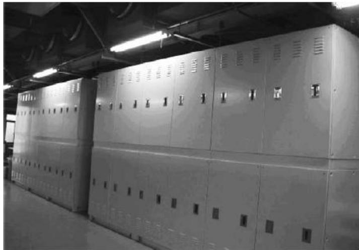
写真1 負荷平準化用 500kWシステム (電池盤)
